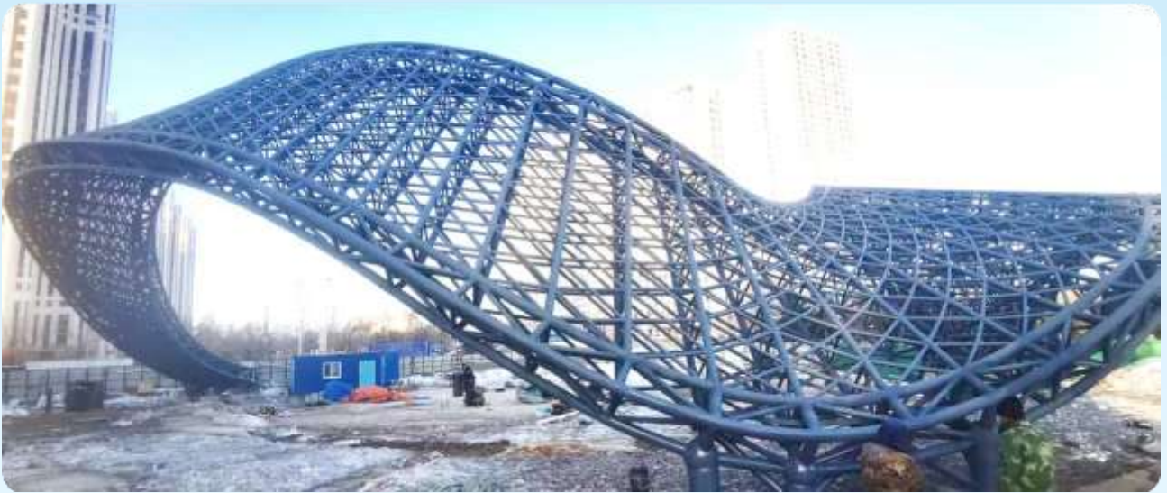
■ 多曲面桁架 / Multi Surface Truss
