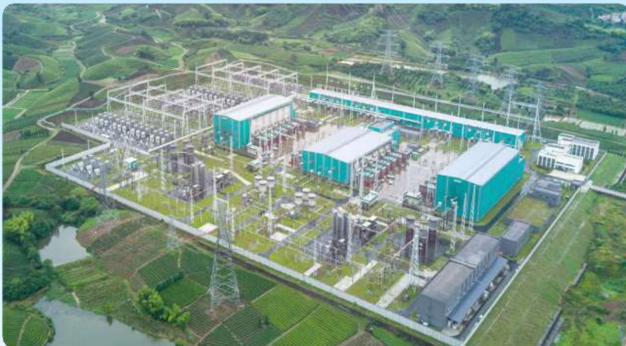
日照35kV变电站建设项目 / Rizhao 35kV Substation Construction Project
