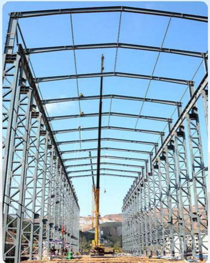
■ 淳化宏远新材料车间建设项目 Chunhua Hongyuan New Material Workshop Construction Project
