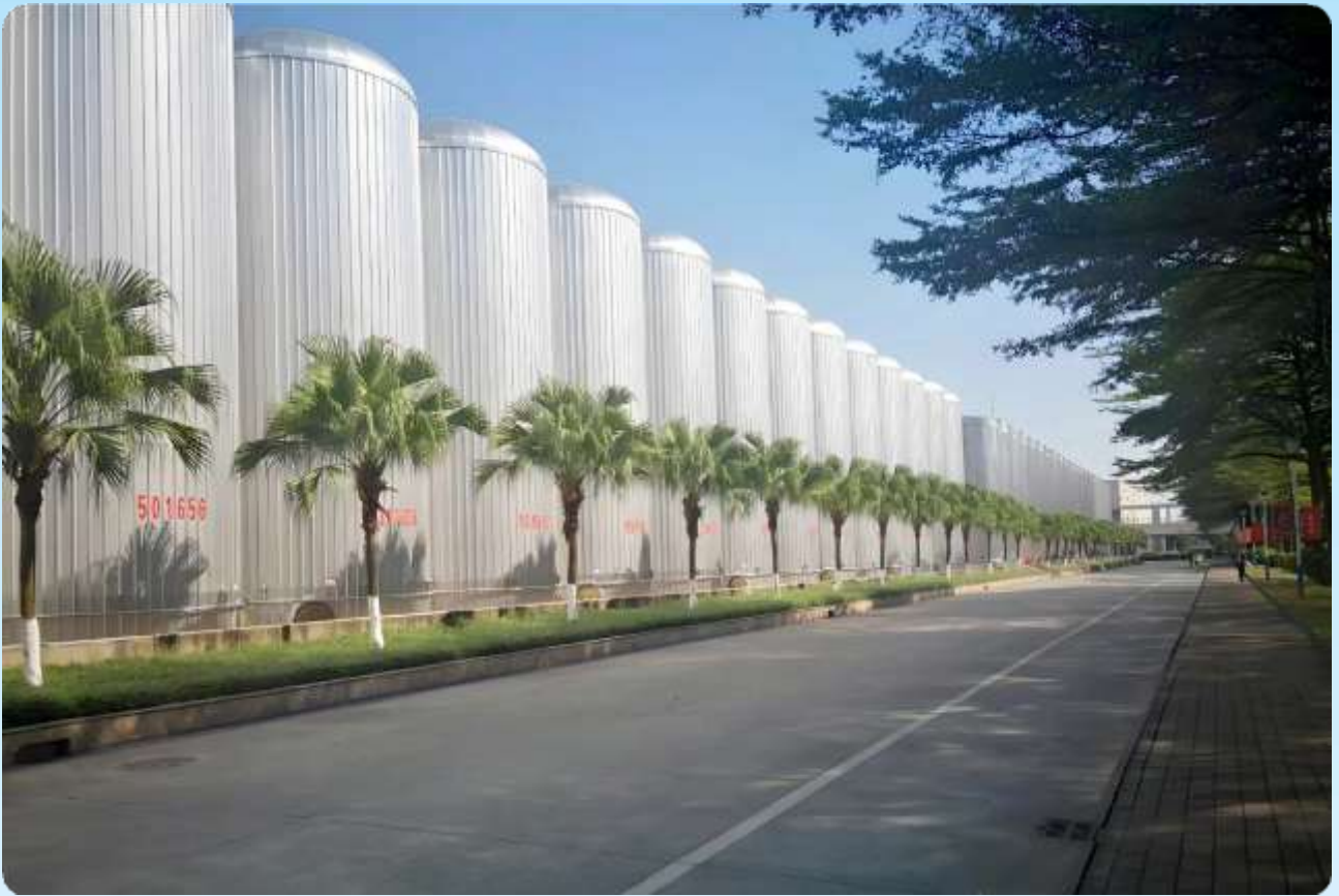
■ 瀚宇新材料科技有限公司防腐保温项目 Hanyu New Material Technology Co., Ltd. Anti Corrosion And Insulation Project
