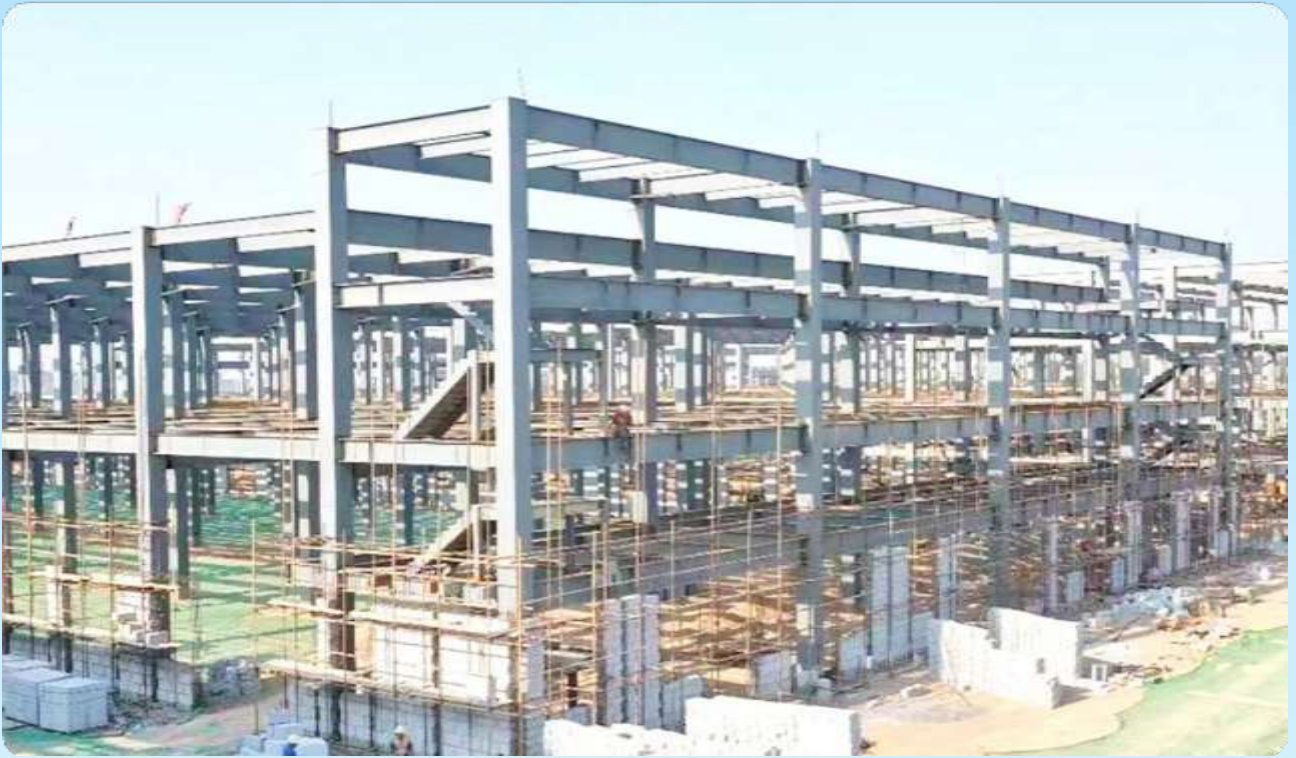
■ 河南综合产业园区项目建设 / Construction Of Henan Comprehensive Industrial Park Project
