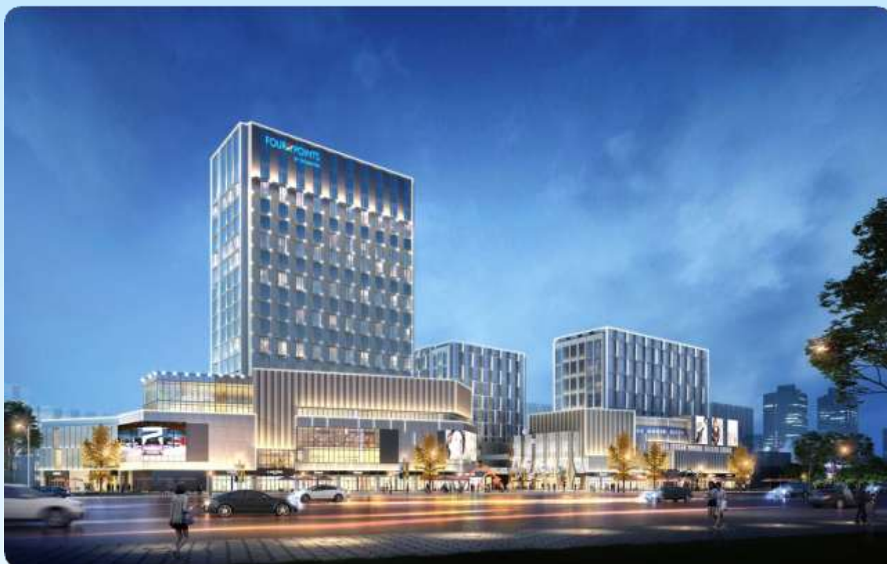
■ 徐州喜悦里商业综合体，建筑面积83279平方米，总造价5.5亿元。
