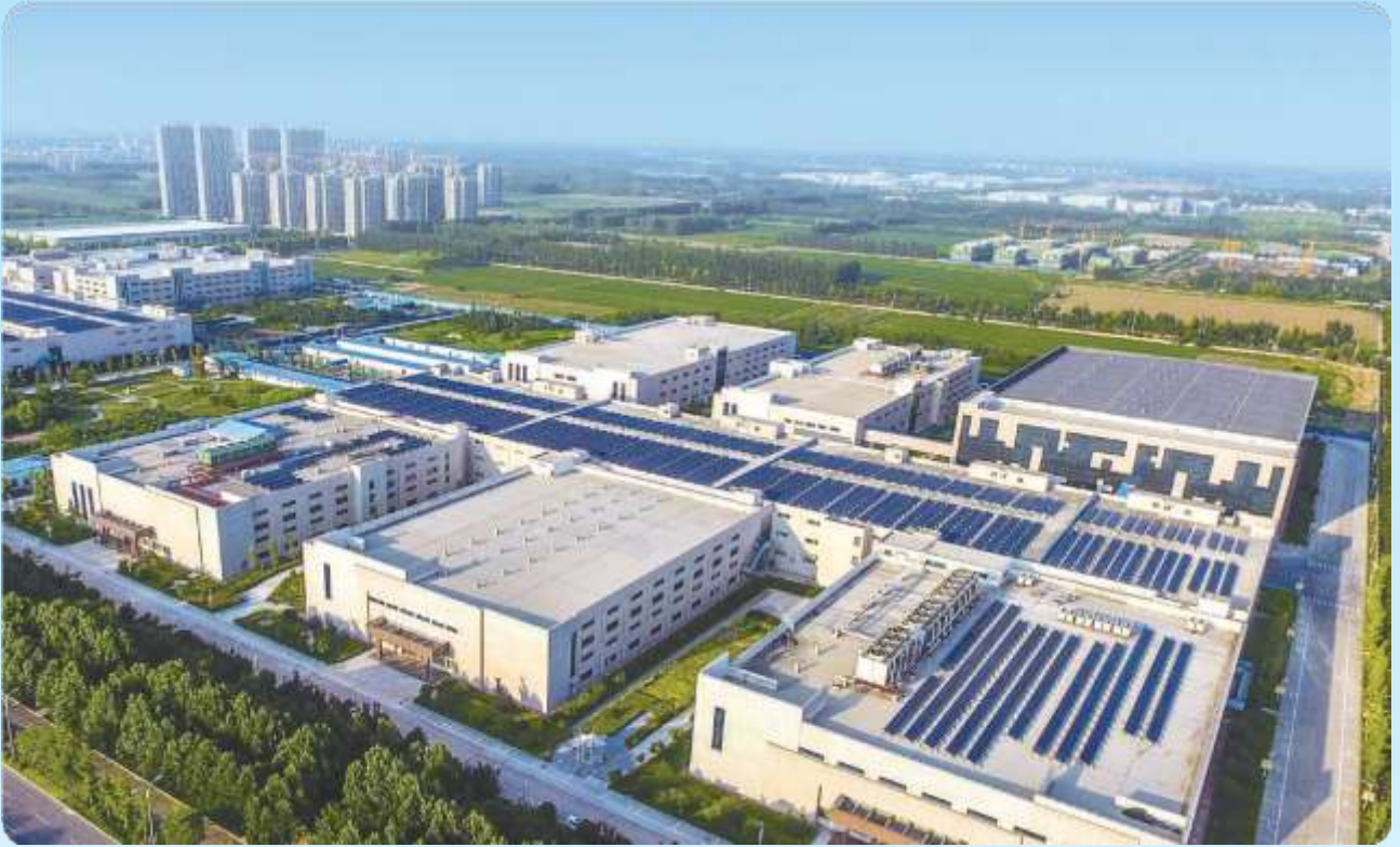
■ 吉利硅谷工业园区项目 / Geely Silicon Valley Industrial Park Project
