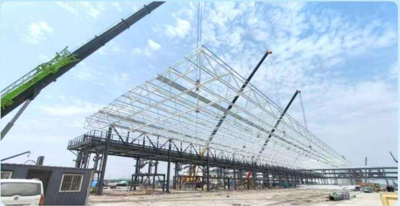
■ 鑫海集团卸车栈台 / Xinhai Group Unloading Platform
