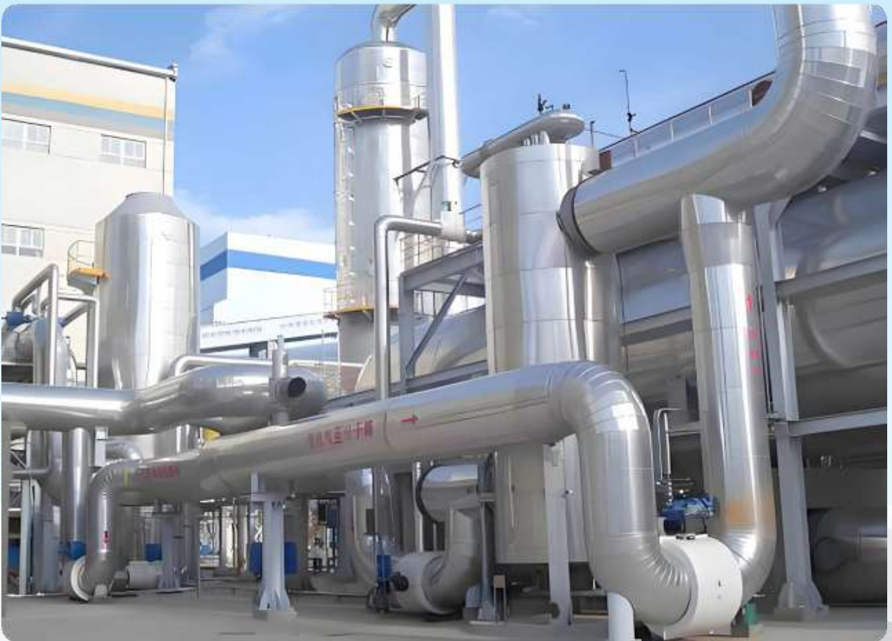
■ 百盛生物科技有限公司防腐保温项目 / Baisheng Biotechnology Co., Ltd. Anti Corrosion And Insulation Project
